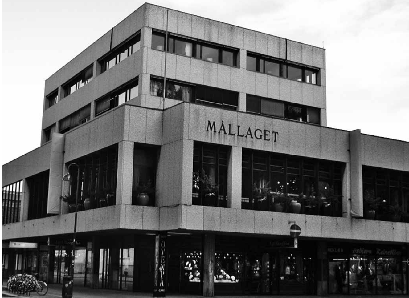
Mållagsbygget i Kristiansand sentrum.
